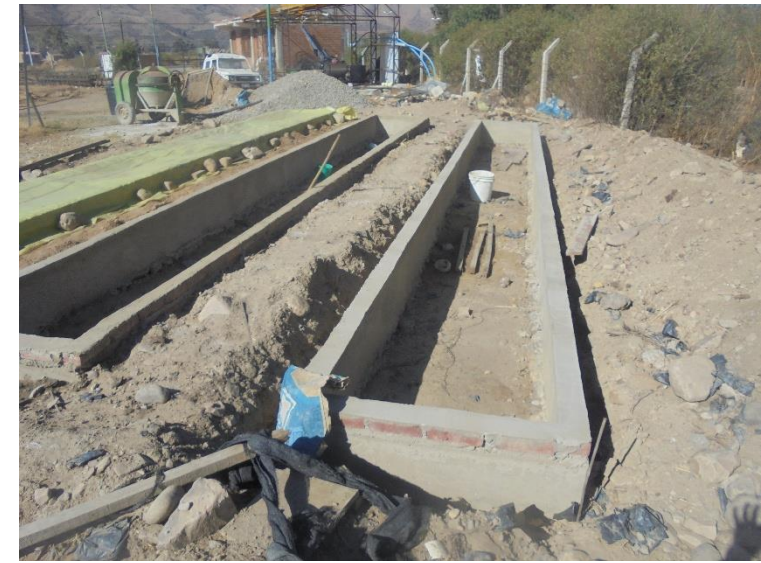
Construcción de almacigueras
