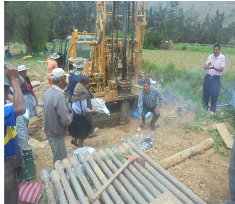
Perf. Pozo Villa Barrientos
