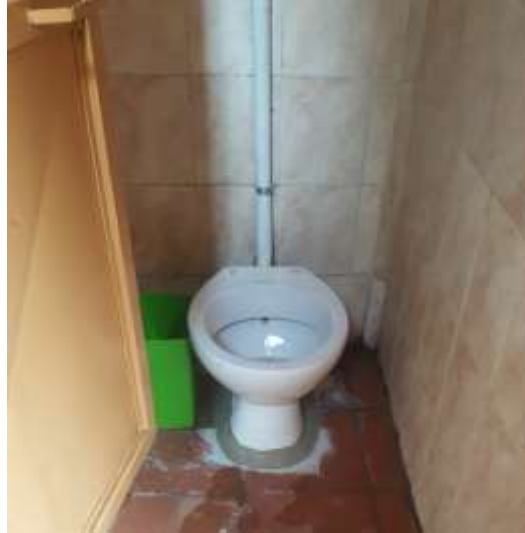
MASILLADO DE LAVAMANOS, SELLADO DE INODOROS Y COLOC . DE LUMINARIAS
