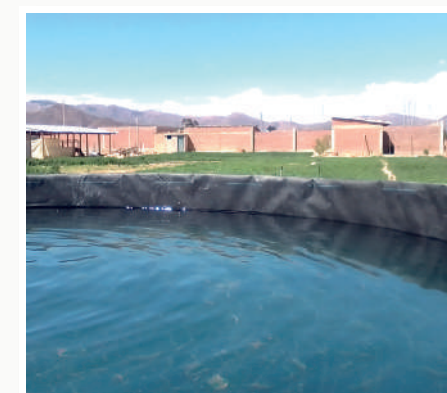
Implementación del tanque australiano
