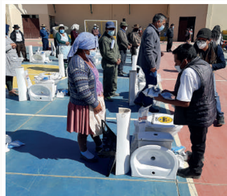
Construcción de 92 baños con arrastre de agua en comunidades del Municipio
