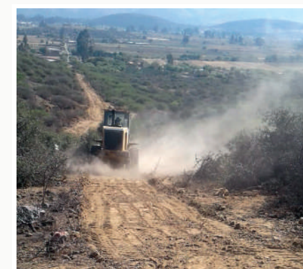
Mantenimiento y apertura de camino Av. Paz
