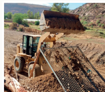
Mantenimiento de camino Eterovich
