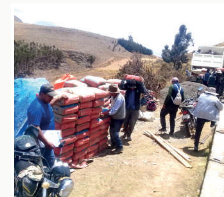
Mejoramiento canal Totora K'ocha
