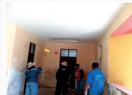
Mantenimiento en Unidad Educativa Sócrates Guillermo Torrico
