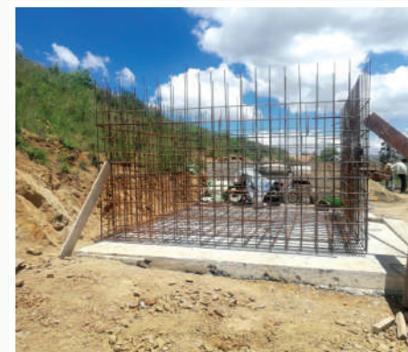
Construcción tanques de hormigón armado de capacidad 22 m3 para zapetas Arachaca - Capilla Chillijchi
